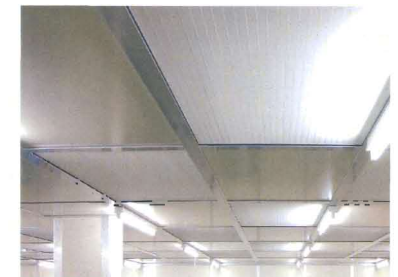
クリーンルーム内(天井へパフィルター) ○ピンポイントでクラス100可能
